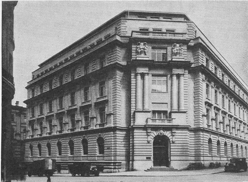
Abb. 2. Das Gebäude nach dem Aufbau (1933) der zerstörten Obergeschosse.
