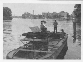
Abb. 2. Luftschrauben-Treibflächenantrieb System Sohn.
