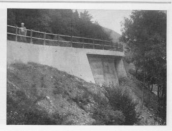
Abb. 10. Stützmauer mit Kragkonstruktion an der Passwangstrasse.
