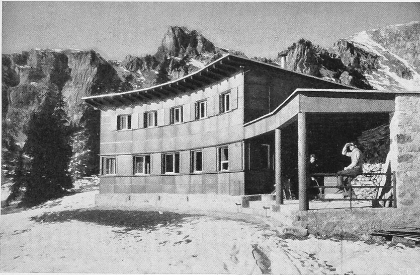
Abb. 2. Ortstockhaus aus Südosten.
