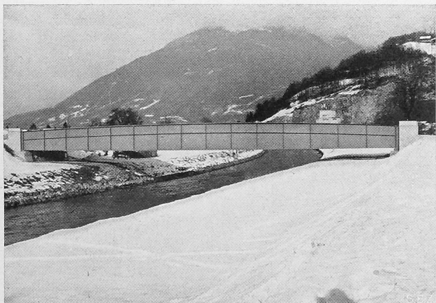
Abb. 6. Neue Linthbrücke bei Mollis, lichte Breite 7,5 m. Stützweite des Blechbalkens 46,0 m; Trägerhöhe 2,4 bis 3,0 m.
