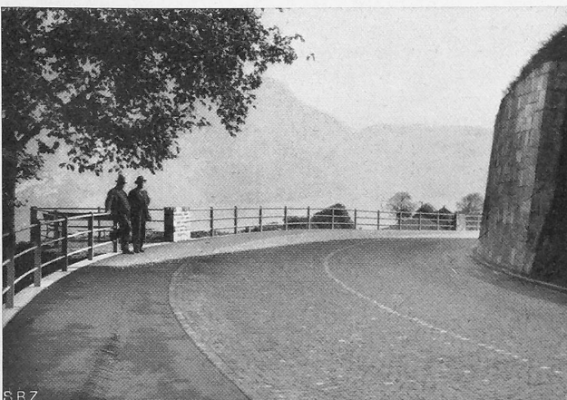
Abb. 11. Beim Sallerntobel; Breite 8,70 m, R aussen 45 m, R innen 50 m.
