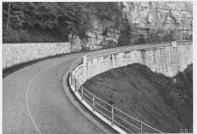
Abb. 12. Im Sallerntobel; Breite 9 m, R aussen 45 m, R innen 36 m.
