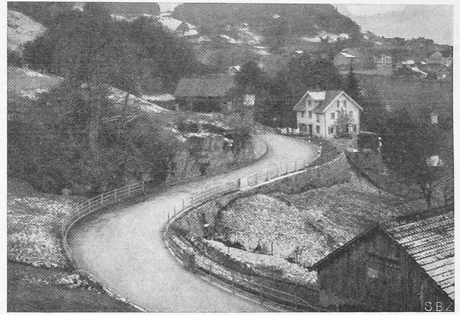
Abb. 8. Ausgebaut auf 8,0 m breit, vorn R 1 40, R a 30 m; hinten R 1 60, R a 50 m.
