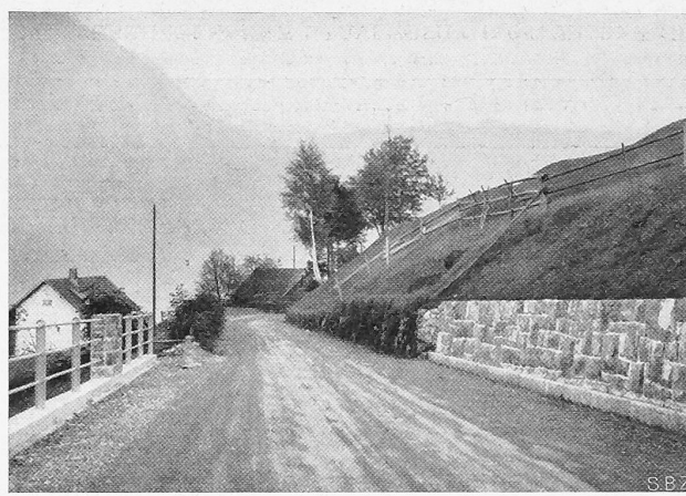
Abb. 10. Ende der Ausbaustrecke im Herbst 1933 bei Stocken, im Hintergrund die alte Strasse 4 1/2 m breit, vorn erweitert auf 6,5 m.
