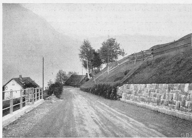
Abb. 10. Ende der Ausbaustrecke im Herbst 1933 bei Stocken, im Hintergrund die alte Strasse 4 1/2 m breit, vorn erweitert auf 6,5 m.
