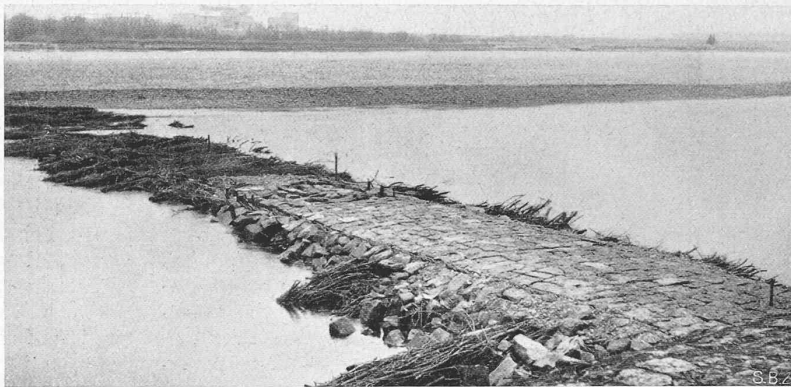
Abb. 5. Bühne zum Abschluss einer Nebenrinne bei bad. Km. 121,3 bei Niederwasser, Q = 478 \text{ m}^3/\text{sec} . Aeusserer Hälfte im Rohbau, innere fertig gepflastert (28. Dez. 1931).
