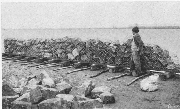
Abb. 16. Bruchstein-Senkurst, bereit zum Abwerfen von der Senkbrücke.
