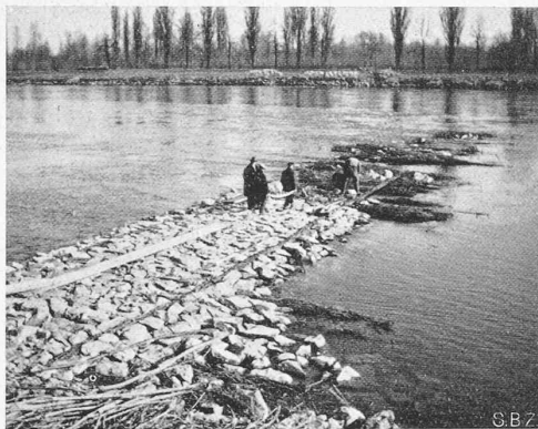
Abb. 4. Bühne im Bau bei franz. Km. 53,429 bei Niederwasser, Q = 456 \text{ m}^3/\text{sec} (18. Febr. 1932).
