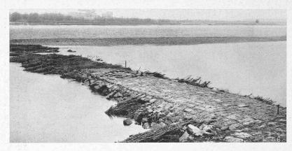
Abb. 5. Buhne zum Abschluss einer Nebenrinne bei bad. Km. 121,3 bei Niederwasser, Q = 478 m³/sec. Aeussere Hälfte im Rohbau, innere fertig gepflastert (28. Dez. 1931).
