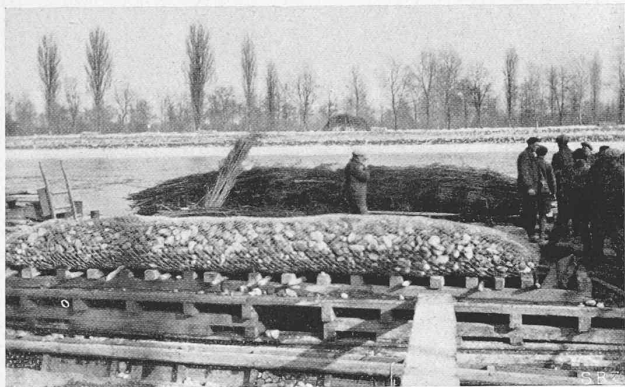
Abb. 15. Wacken-Senkurst mit Drahhülle; dahinter Faschinenwurf.
