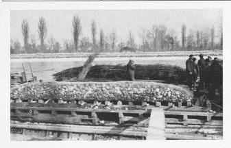
Abb. 15. Wacken-Senkwurst mit Drahthülle; dahinter Faschinenwurst.
