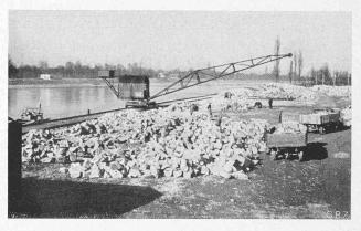
Abb. 13. Steinlagerplatz Griessheim. Dampfdrehkran mit 20 m Ausladung.
