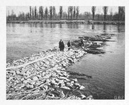
Abb. 4. Buhne im Bau bei franz, Km. 53,429 bei Niederwasser,  $Q = 456 \text{ m}^3/\text{sec}$  (18. Febr. 1932).
