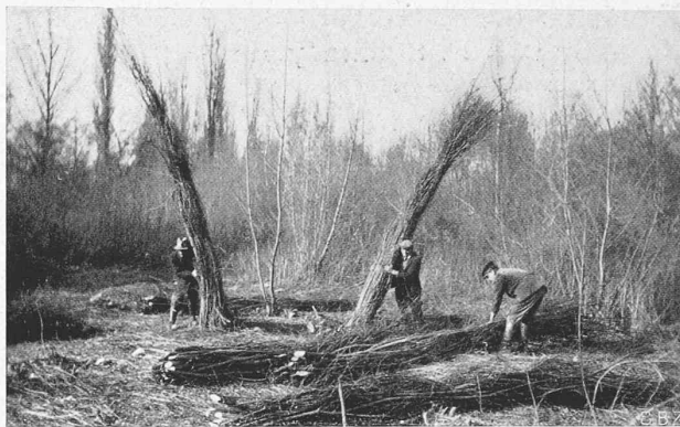
Abb. 17. Faschinenbinden im Unterholz der Rheinniederungen.
