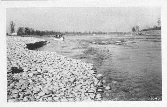
Abb. 9. Kiesbank-Abtrieb (franz. Km. 37,6) infolge Herüberdrückens des Wassers durch die Buhne bei bad. Km. 36,003. Q  $462~\rm{m^3/sec}$  (14. März 1932).
