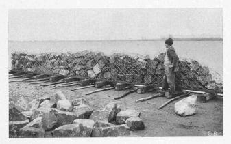
Abb. 6. Bruchstein-Senkwurst, bereit zum Abwerfen von der Senkbrücke.
