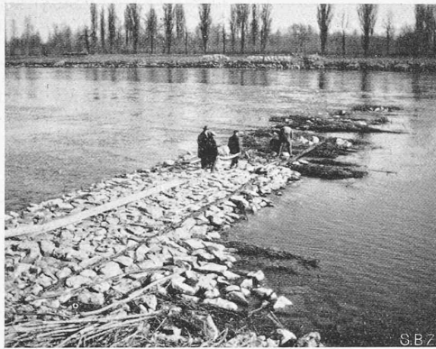
Abb. 4. Bühne im Bau bei franz. Km. 53,429 bei Niederwasser, Q = 456 \text{ m}^3/\text{sec} (18. Febr. 1932).
