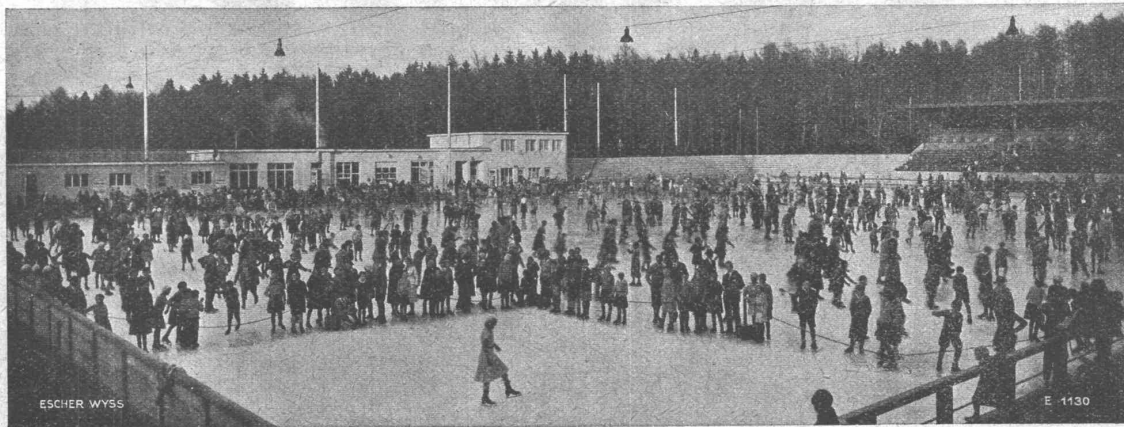
Freiluft-Kunsteisbahn Dolder in Zürich mit einer Eislauffläche von 5600 m 2 , Erweiterung 1932
