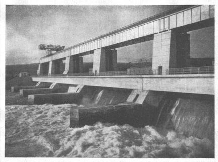
Ausführung des Wehres mit Damm, Uferverbauung und Kanaleinlauf Wehr mit fünf Oeffnungen à 25 m, wovon zwei offen, drei pneumatisch ausgeführt.
