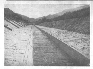
Niederwasserrinne der Augstbachkorrektion Balsthal mit Eisenbetoneinbau, fabriziert von Hunziker & Co., Olten.
