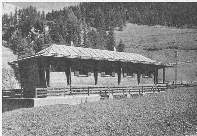
Abb. 3. Grenzwächterhaus Avers-Cröt, gegen SO, taleinwärts gesehen.
