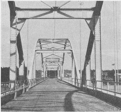
Abb. 19 und 20. Strassenbrücke über den Angermanälven bei Asele (Schweden). Versteifte Stabbögen 72 + 49 + 49 m Stützweiten.
