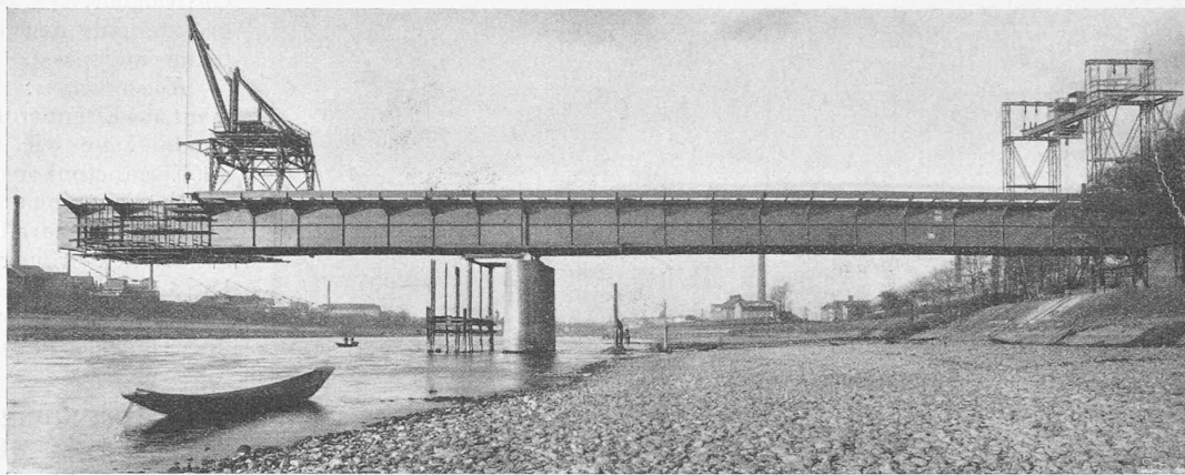
Abb. 3. Die vollendete rechte Hälfte des Ueberbaues. — Abb. 4 (unten). Blick vom linken gegen das rechte Ufer.
