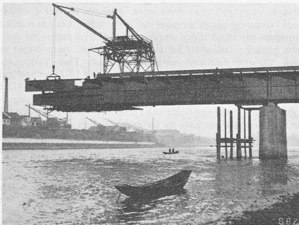
Abb. 1. Gesamtansicht von der Johanniterbrücke rheinabwärts. — Abb. 2 (unten). Einsetzen des letzten Hauptträger-Oberteils.
