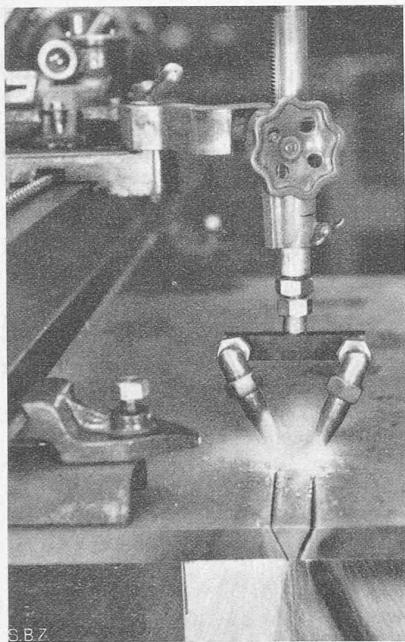
geschrägt. Das mit Oxy-Acetylen betriebene Werkzeug schneidet aus 6 bis 25 mm dicken Platten Kanten von 60, 75 oder 90° Schrägen aus. (Engineering, 8. September 1933.)
