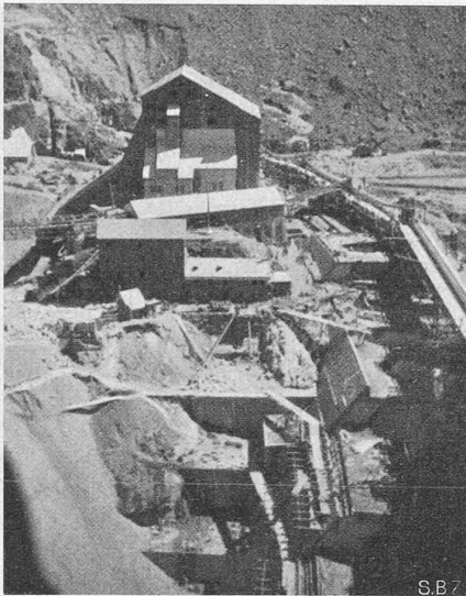
Abb. 9. Luftseitiger Mauerfuss aus Westen (3. Sept. 33).
