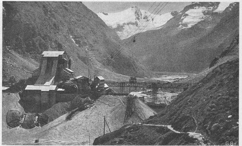
Abb. 3. Mauerbaustelle und Staubecken aus Norden gesehen. Bauzustand Mitte August 1933.
