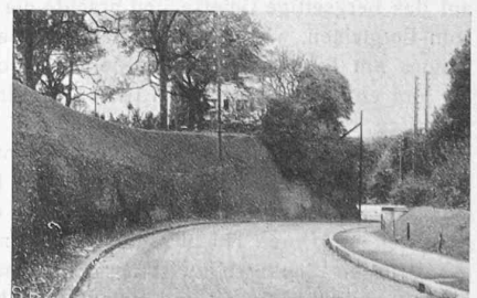
Zürcherische Kant. Strasse II. Kl., Gubel bei Wald. Abb. 5 aufwärts, Abb. 6 abwärts: Sichtweite 90 m; R 90 m und 70 m; Gefälle 8%; Kleinplästickung.
