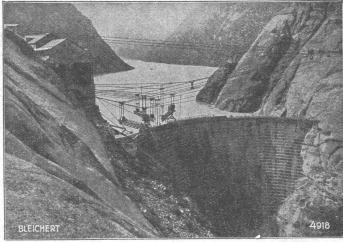
Betonieranlage mit 2 Kabelkranen, 2 Gießbühnen u. 2 Arbeitsbühnen
