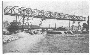
Verladebrücke, tetale Brückenlänge 73,5 m, Spannweite 50 m, Tragkraft 6,5 t, zum Umschlag von Sand und Kies und Transport von Röhren und Formsteinen.
