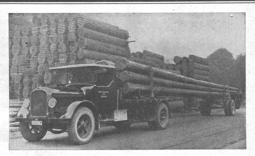
Die Berna-Lastwagen 5-6 t eignen sich vorzüglich für die allerschwersten Arbeiten im Baugewerbe. Dreiseitenkipper, Langholzwagen mit Spillvorrichtung u. Drehschemel. Kräftige Benzin- u. Rohölmotoren; hydraulische Vierradbremse
