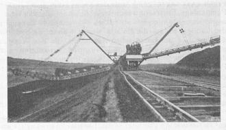
Abb. 11. Eimerbagger mit Transportband, "Kanal Mussolini".
