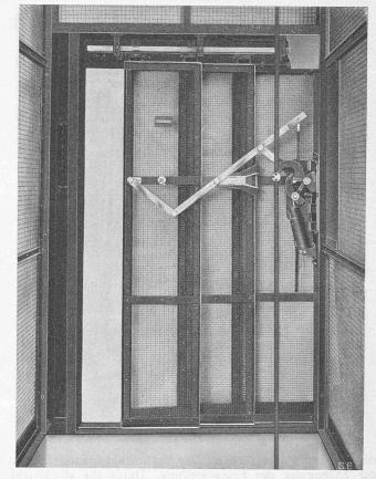
Abb. 17. Automatisches Oeffnen der Schachtfüren.
