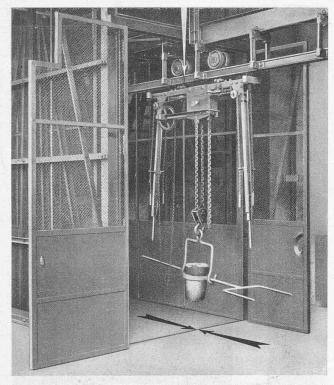
Abb. 9. Fahrstuhl mit Feinabstellung, auf wenige mm genau.
