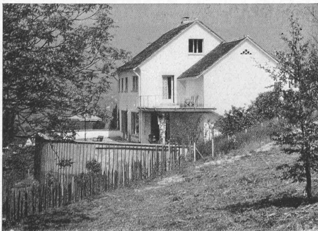
Abb. 2. Gesamtbild des Hauses Weckherlin aus Südosten.
