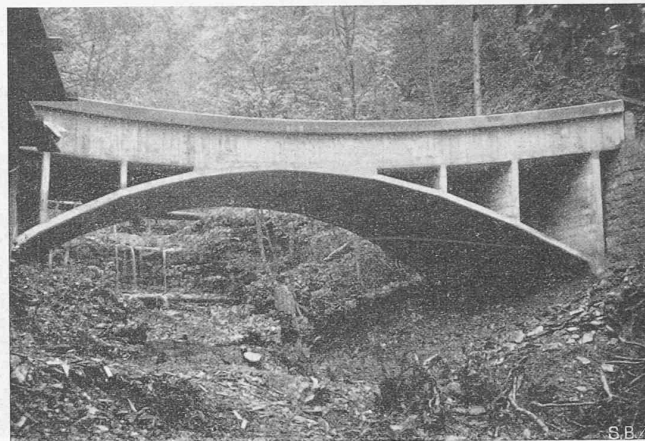
Abb. 3 und 4. Fertige Bohlbachbrücke, Stützweite 14,40 m, Strassenaxe R = 15 m, Steigung 8‰.
