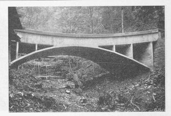
Abb. 2. Betonieren d. Fahrbahntafel.
