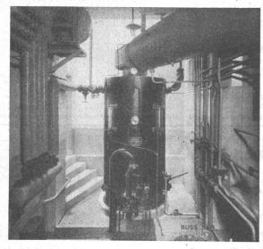
I cd-Kesselanlage mit Oelfeuerung und Speisewasservorwärmer im Erdgeschoss eines Wohnhauses.
