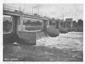
Stauwehr Dietikon des E. K. Z. Vier Oeffnungen à je 14,0 m. Stauhöhe 3,3 m. — Doppelschützen in Dieieck-Fachwerkkonstruktion. — Elektr. Windwerke für 30 Tonnen bezw. 60 Tonnen Hubkraft.
