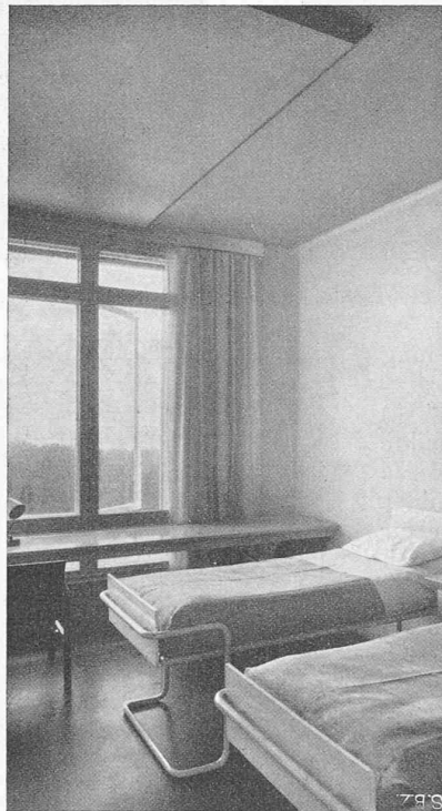
Abb. 9. u. 10. Tuberkulose-Sanatorium Paimio in Finnland, Arch. Alvar Aalto. — Krankenzimmer mit an der Decke sichtbar montierter Paneelheizung (entgegen der üblichen unsichtbaren Ausführung).
