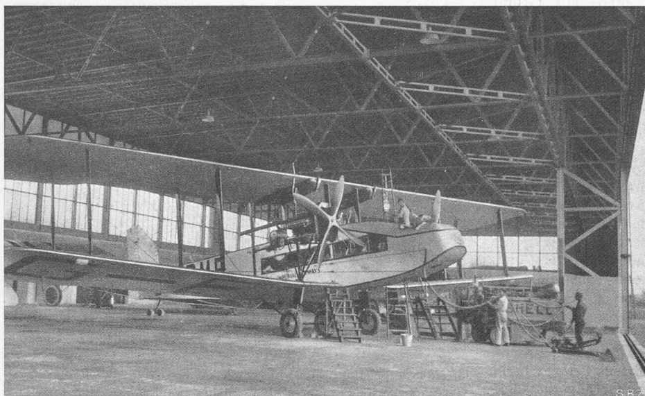
Abb. 28. Inneres des Hangars, rechts die Mittelstütze des Torträgers.
