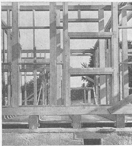
Abb. 6. Holzfachwerk mit Sprossen für Ondulexplatten.
