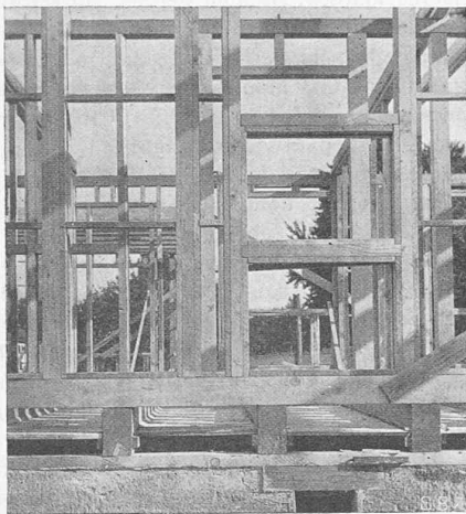
Abb. 6. Holzfachwerk mit Sprossen für Ondulexplatten.
