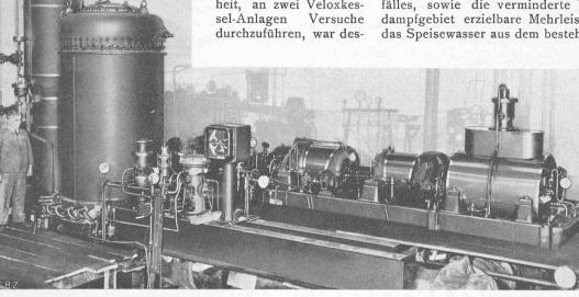
Abb. 1. Veloxkessel-Versuchsanlage in der Fabrik von Brown, Boveri & Cie. in Baden.
