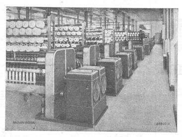
Antrieb von doppelten Baumwoll-Ringspinnmaschinen mit Dreiphasen-Kommutatormotoren.
