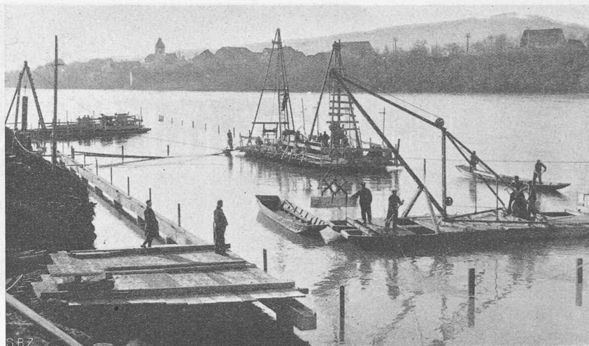
Abb. 16. Montage der fertigen Eisenbetonteile: die Dip für die Führung der Balkenwände sind sichtbar. Die Randbalken am Ufer (links in Abb. 13) sind bereits verlegt.
