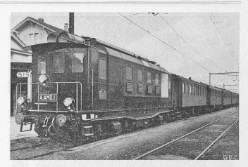
Abb. 1. Diesel-elektrische Rangierlokomotive der PLM-Bahn; Probefahrt.
