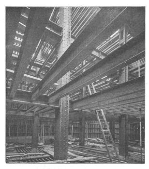
Tresorkonstruktion eines Bankgebäudes
