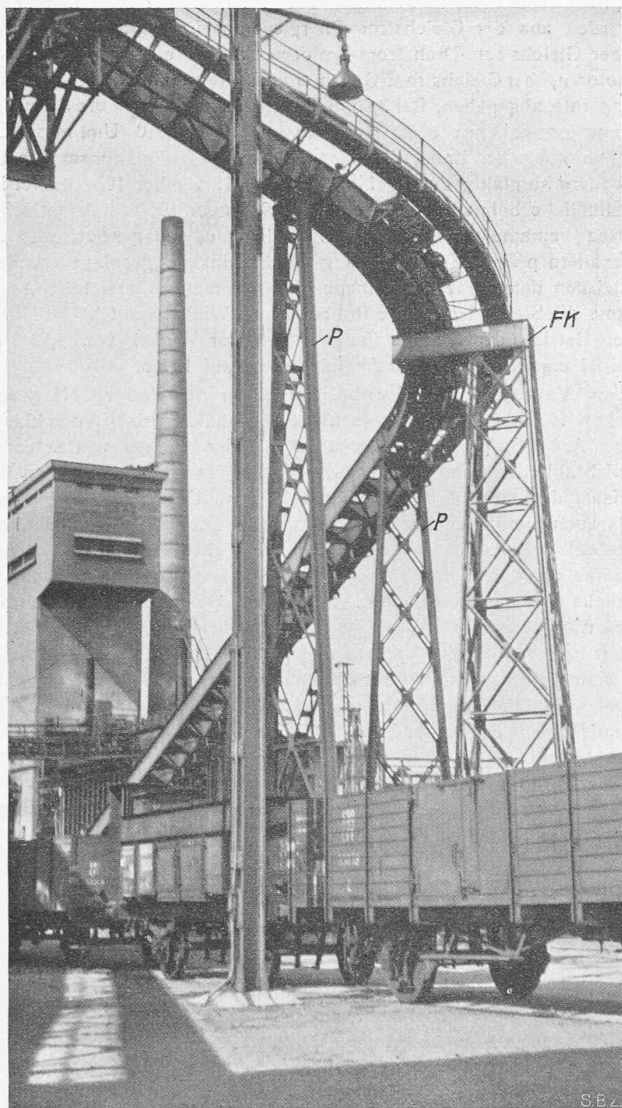
Abb. 12. Blick in den gekrümmten Teil der Koks-Förderbrücke. FK feste Stütze mit Konsole zur Lagerung der gekrümmten Brücke. P Pendelstützen an den Enden der gekrümmten Brücke.
