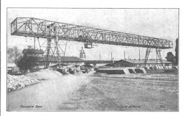
Verladebrücke, totale Brückenlänge 73,5 m, Spannweite 50 m, Tragkraft 6,5 t, zum Umschlag von Sand und Kies und Transport von Röhren und Formsteinen.
