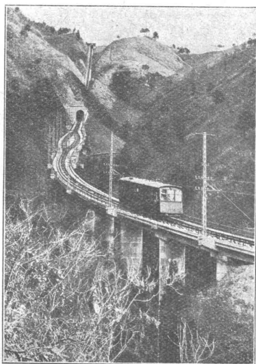
Eine der leistungsfähigsten Seilbahnen der Welt, die Seilbahn „Shigisan“, Japan, mit Wagen für 200 Personen und einer Fahrgeschwindigkeit von 3,13 m/sec, bei 46,7 % Steigung. — Erbaut 1930.
