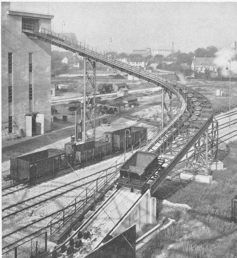
Abb. 1. Gesamtbild der Rohkohlen-Förderbrücke.
