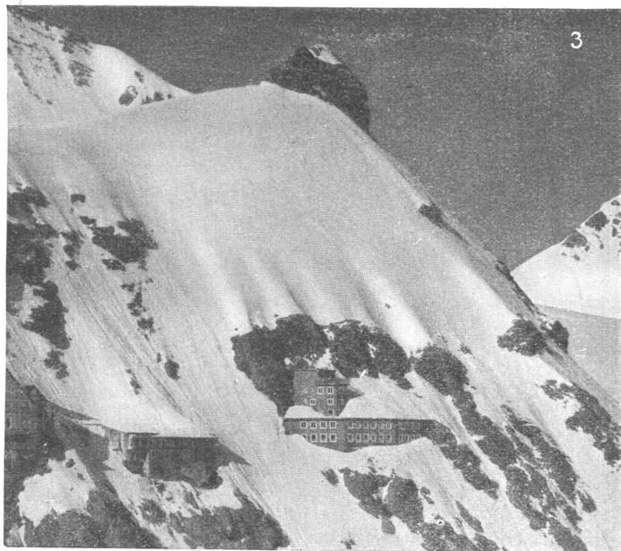
Hochalpine Forschungsstation Jungfrauoch Asphaltoid-Isolierung der Terrassen ca. 420 m 2 Arch.: Gebr. Pfister, Zürich.
