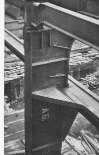
treten. Die Verlaschung der Flansche erfolgt durch Stumpfschweissung und gleichzeitige Unterstützung durch Laschen.
