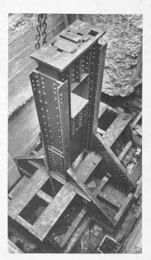
Abb. 3. Fundamentstütze mit Fussgelenk.
