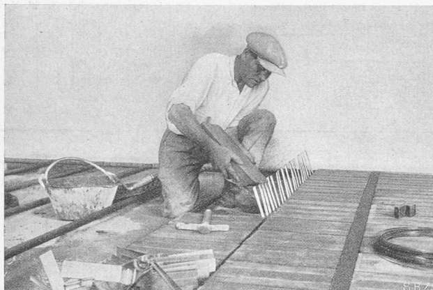
Abb. 2. Einschieben der Hourdi über die Verteilerenden.
