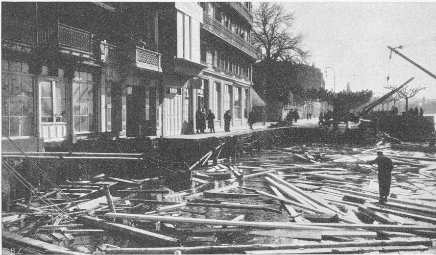
Abb. 9. Ansicht des Quai-Absturzes vom 22. März 1933, gegen Osten. — Photos E. Rieder, Vevey.
