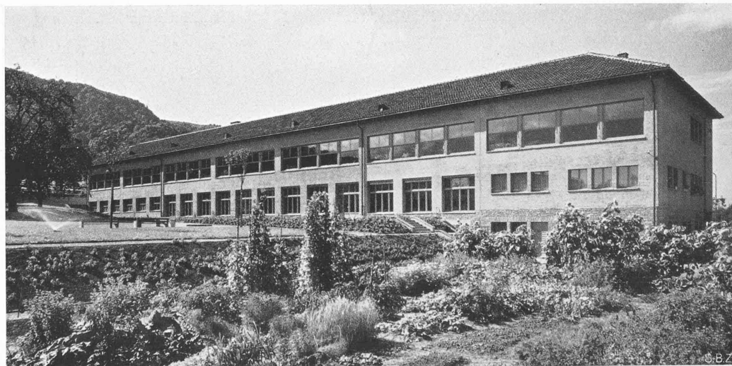
HAUPTFRONT AUS OSTEN, RECHTS DIE HAUSWARTWOHNUNG
