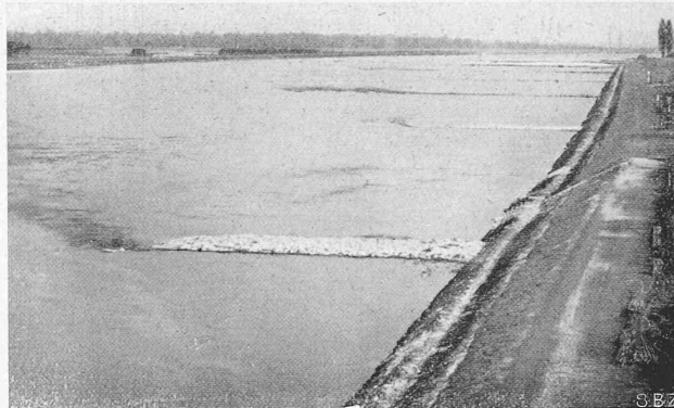
Abb. 10. Ausgebaute Buhnenreihe am rechten Ufer bei Marlen, bei Niederwasser, Q 478 m³/sec, bad. Km. 118 bis 119 (26. März 1932).
