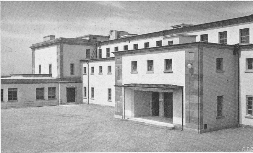
Abb. 22. Diensthof mit Anfahrt der Leicheneinlieferung, links das niedrige Ofenhaus.
