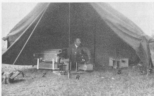
Abb. 3. Beobachtungszelt für Zeitmarkierung, Registrierung und Seismometer.
