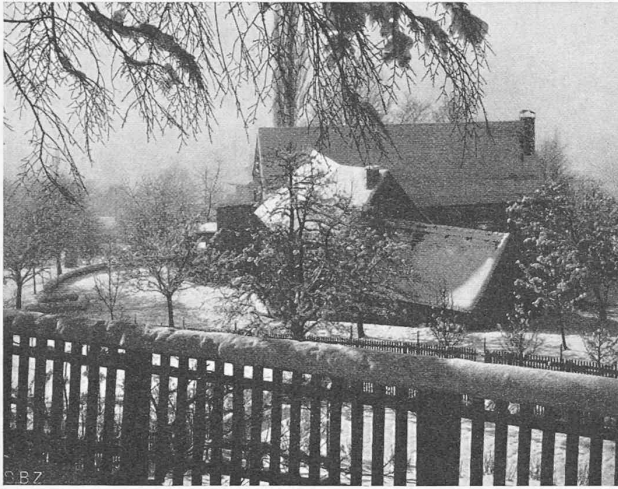
Abb. 2. Ansicht von der Bergseite, aus Norden.
