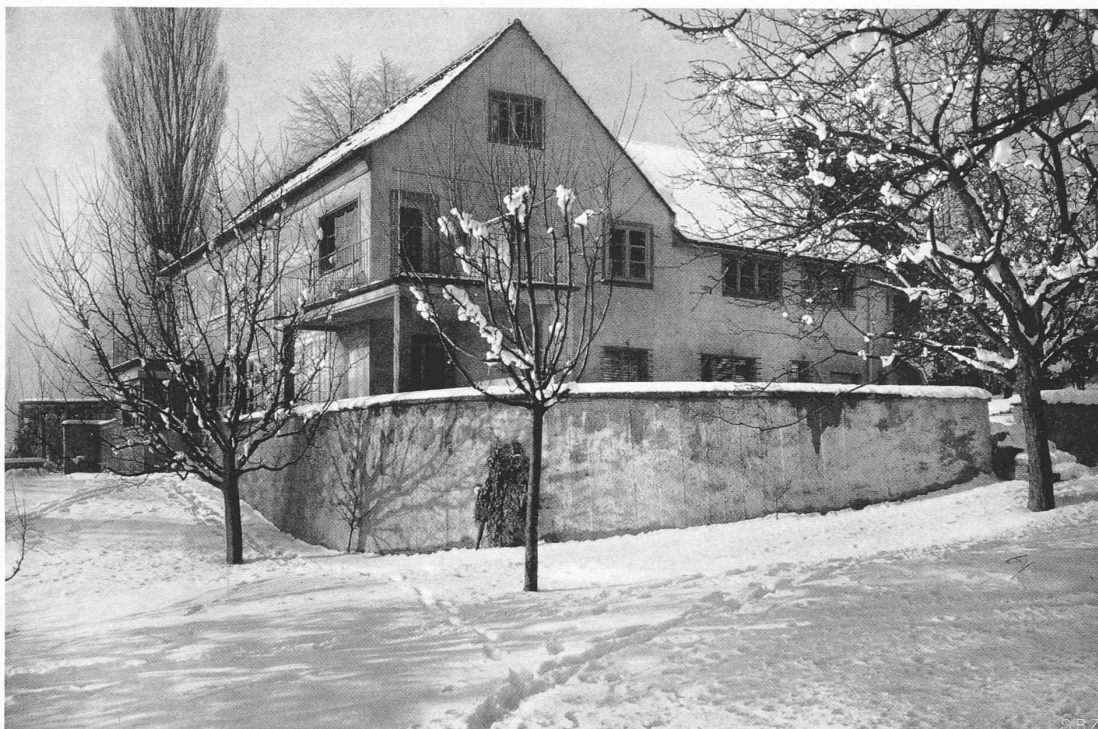
Südostansicht vom Garten aus.
