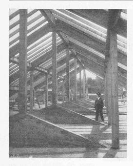
Abb. 18. Blick in den Eisenbeton-Dachstuhl mit hölzerner Sparrenlage. – Ing. R. Maillart, Zürich-Genf.
