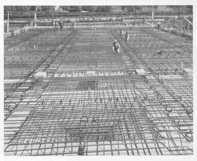
Abb. 21. Pilzdecken-Armierung über der Turnhalle C (Boden von Halle B). - Ing. R. Maillart.
