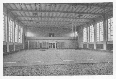
Abb. 11. Turnhalle B, für Leichtathletik; Holzpflästerung, im Vordergrund Schwingboden.
