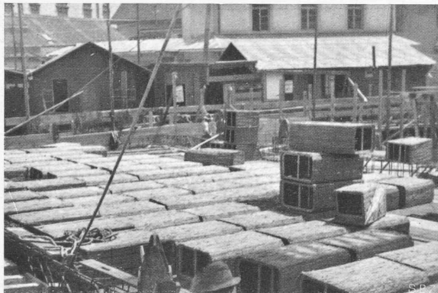
Abb. 39. Verlegte Rohrzellen.
