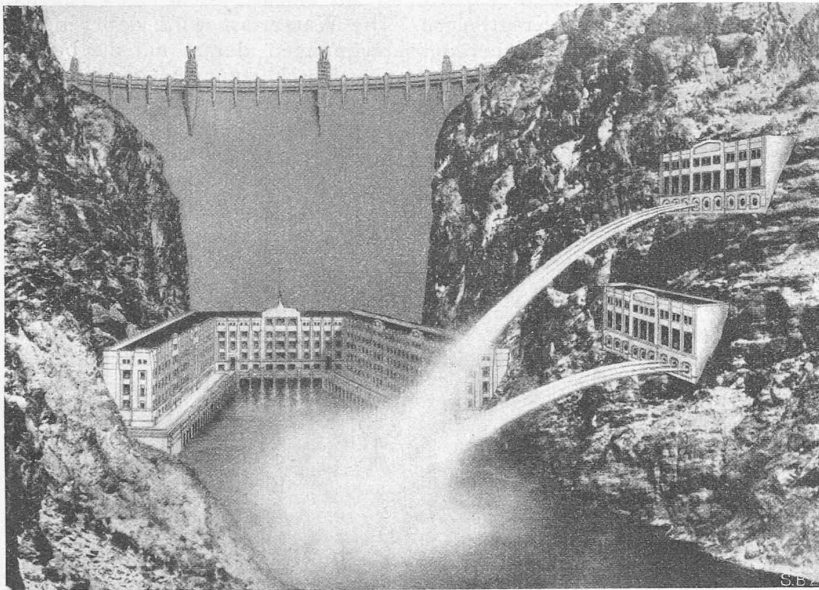
Abb. 2. Hooverdamm-Kraftwerk in der Colorado River - Schlucht; rechts die „Auslass-Werke“.
