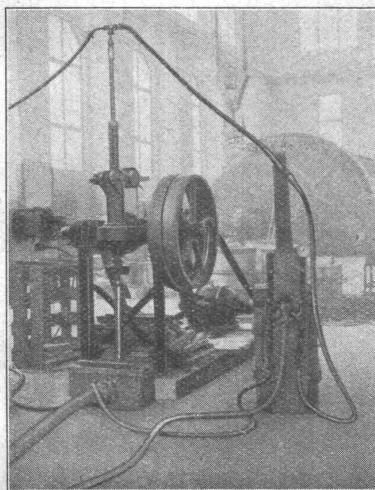
Konsolidation eines Generatorfundamentes mit Hilfe von Kernbohrungen. Verankerungsseile und Injektionen.
