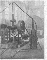
Konsolidation eines Generatorenfundamentes mit Hülfe von K bohrungen. Verankerungselsen und Injektionen.
